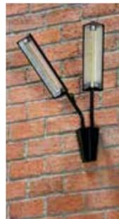
L'église, jusqu'alors dotée d'un système de chauffage par le sol en partie défectueux et particulièrement énergivore, s'est vue équiper cet été de chauffages radiants pouvant être gérés selon la saison, disposant d'une temporisation, et offrant une chaleur immédiate en ne consommant d'énergie que le temps nécessaire.
